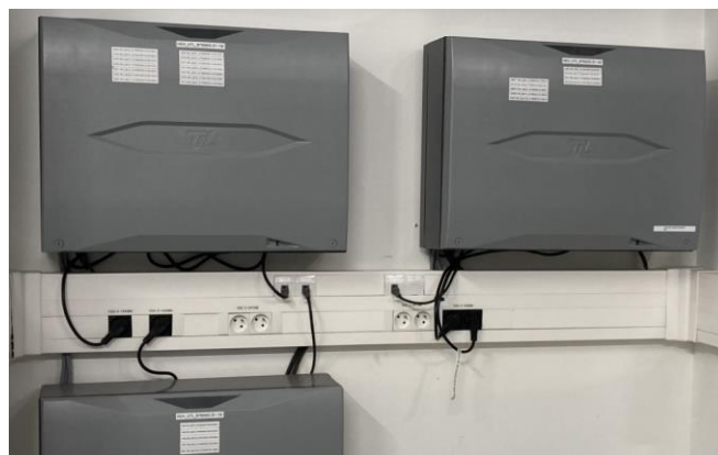
Exemple de 3 UTL de contrôle d'accès. Pour chaque UTL, il y a une prise réseau, une prise de courant ondulé (PCO) et une prise de courant normal (PCN).
