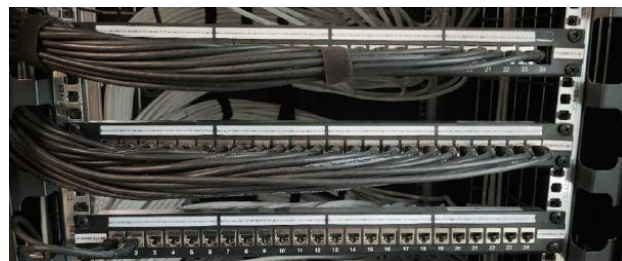
Les cordons de brassage seront attachés avec du velcro
