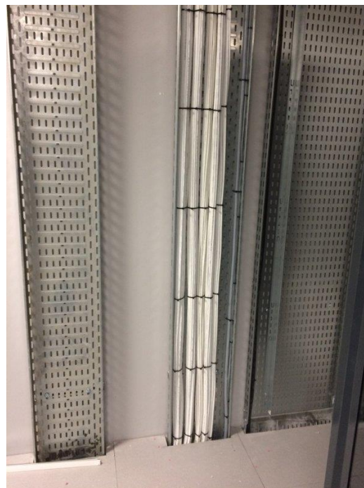
Exemple de chemin de câble vertical dans un LCB.
