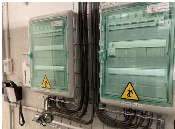
Exemple de coffret électrique pour un LCB
