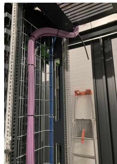
Cablofil dans les baies passives
