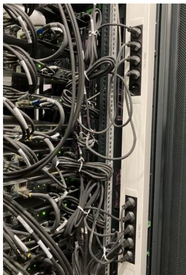
Alimentation des switchs via des prises PCB et PCN encastrées dans des goulottes PVC
