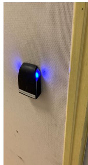
Lecteur de badge à l'entrée d'un LCB. En standard, pas de clé.
