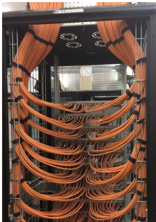
Les câbles VDI arriveront des 2 côtés de la baie et seront répartis proprement, sans surlongueur
