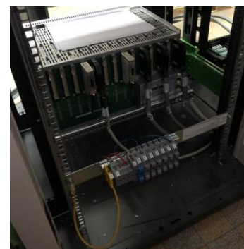
Alimentation électrique du châssis 4400
