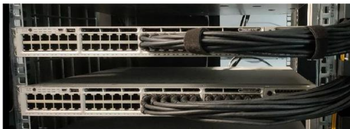
Le brassage des cordons devra être réalisé de manière à permettre la maintenance des switchs
